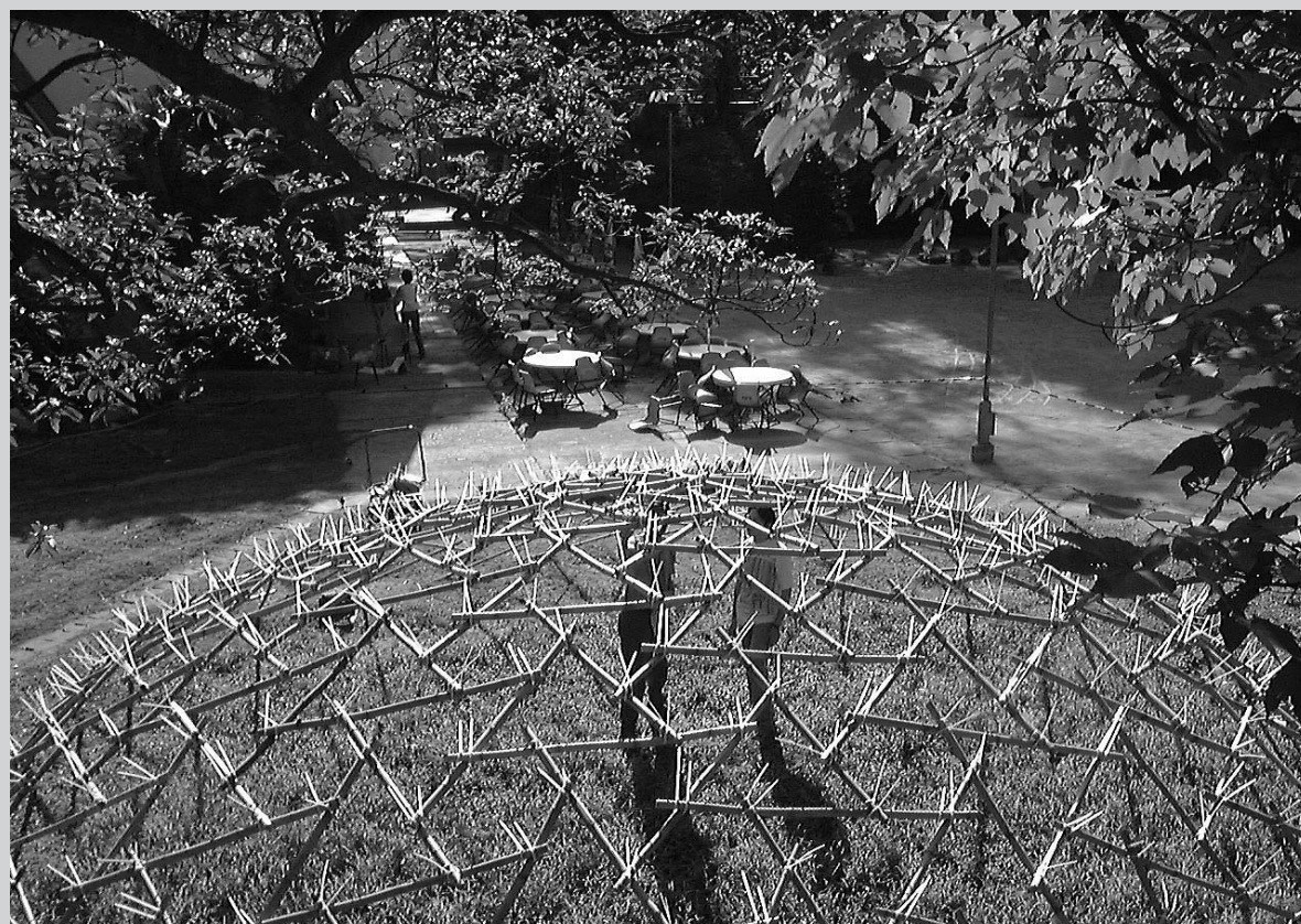
Im Sommer 2000 wurde zur Überprüfung der Ergebnisse der wissenschaftlichen Studie ein Bambusdom von etwa 10 m Durchmesser und 2 m Höhe errichtet.
